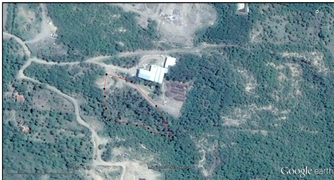
Ilustración 5 Planta de Tratamiento
